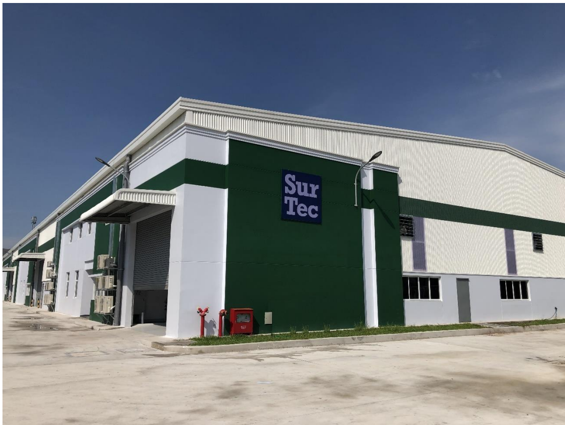
Datei 2: Außenansicht Produktionsgebäude
